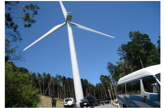
▲低周波音被害で有名になった天目山風車
