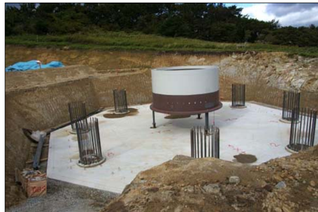
↑滝根小白井風力発電建設現場 2009年9月撮影
